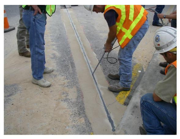
AFTER A BACKER ROD IS PLACED INTO THE JOINT FOR PROPER DEPTH, JOINT FILLER IS INSTALLED.
